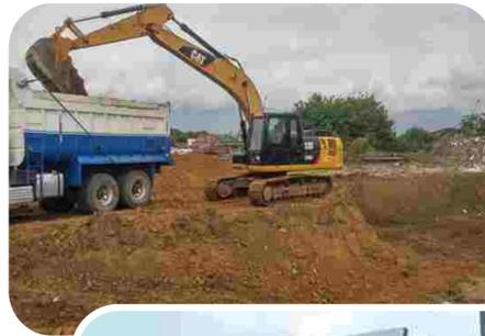
Con el cerramiento de la obra, colocación de vallas informativas e inicio de las excavaciones, arrancan las obras de reforzamiento y reconstrucción del primer tramo de 6,7 km del anillo de jarillones, que protegen a Cali del riesgo por inundación, asociado al río Cauca.
